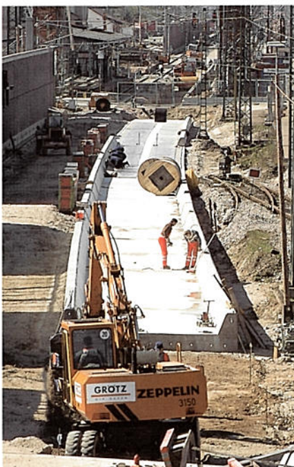
Bau der Erprobungsstrecke
